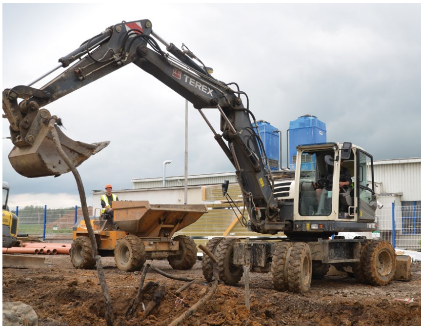
Kolové rýpadlo TEREX TC110, dodané firmou ASbud, najdeme v těchto dnech průmyslové zóně v Lanškrouně, kde firma HORKON staví příjezdovou cestu. V době naší návštěvy vykopávali rýpadlem ze země staré rezavé trubky, dlouhé i přes pět metrů.
