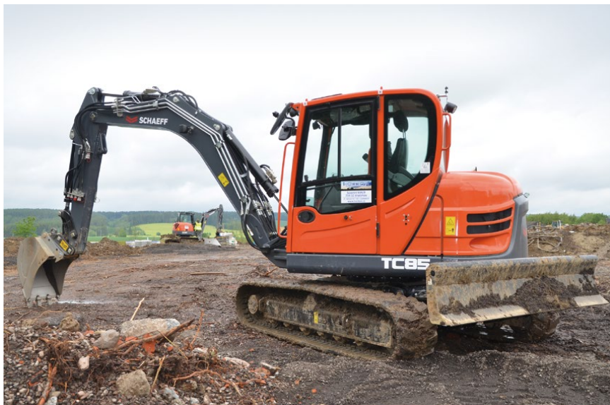
Na stavbě skladovací haly ve Svitavách pracují dvě zánovní rýpadla SCHAEFF, dodané firmou ASbud. V popředí větší rýpadlo SCHAEFF TC85 (8,2 t), vzadu pak menší sourozenec SCHAEFF TC50 (5 t).
